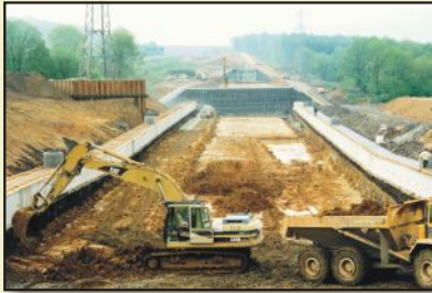
Bodenaushub im Rahmen von Baumaßnahmen
