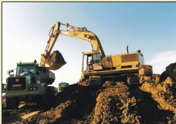
Aushub von Bodenmaterial
